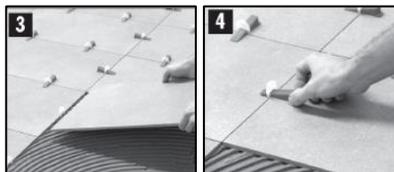
Beim Setzen der Nivellierkeile in die Nivellier-Zuglaschen den Bruch-punkt nicht überschreiten. (4)
