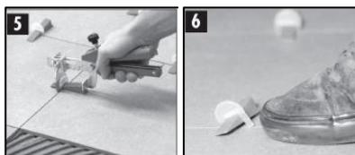
Das Entfernen der Verlegehilfe erfolgt sobald der Klebemörtel abge-bunden hat. Der vorstehende Teil der Nivellier-Zuglasche kann mit einem Gummihammer oder Schuh parallel zur Fuge abgeschlagen werden. (6) Die Nivellierkeile können wiederverwendet werden.
