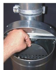
Um die Standsicherheit der gesamten Rohreinheit zu gewährleisten, können in Abhängigkeit der vorhandenen Rohrbefestigungen ggf. noch zusätzliche Rohrschellen notwendig werden. Dabei sollte der Abstand der unteren Rohrschelle zum Laubfangboden bzw. der oberen Schelle zum Laubfangdeckel ca. 10 cm betragen. (Bild 4)
