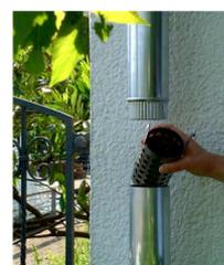
Jetzt kann das obere Rohr mit dem Schiebestück in seine ursprüngliche Position zurückgebracht werden. Durch Herunterziehen des Schiebestückes ist das Rohr wieder geschlossen.
