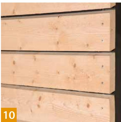
SOLITEX FRONTA QUATTRO ist geeignet für Konstruktionen mit vorgehängter Lückenschalung. Max. 35 mm Lücke, mind. 2 cm Hinterlüftung zwischen Bahn und Lückenschalung. SOLITEX FRONTA QUATTRO ist für diese Anwendung schwarz bedruckt, damit die Schrift nicht durch die Fugen scheint.
