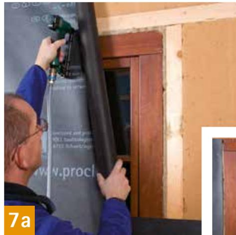
An Fensteröffnungen Bahnen durchgehend verlegen und umlaufend durch Tackern fixieren. Anschließend mit einem Cuttermesser die Öffnung aufschneiden. Bei zurückspringend eingebauten Fenstern Bahn gemäß Skizze einschneiden und bis zum Blendrahmen in die Leibung führen.
