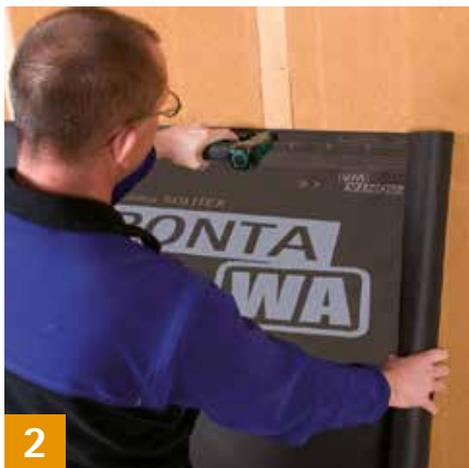
Befestigung der Bahnen erfolgt feuchteschutz im oberen Drittel des Überlappungsbereichs der später überdeckenden Bahn und in Bereichen, die anschließend durch die Konterlattung überdeckt werden. Verzinkte Klammern (mind. 10 mm breit – 8 mm lang) verwenden. Befestigungen dürfen nicht in Bereichen erfolgen, in denen Wasser gesammelt abfließt.
