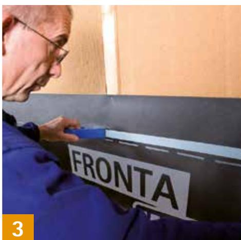
Verklebung mit doppelseitigem Klebeband DUPLEX erfolgt feuchteschutz im unteren Drittel der späteren Überlappung. Aufgedruckte Strichlinie dient zur Orientierung. Einfaches Aufbringen des Klebebands mit dem DUPLEX Handdispenser (geeignet für 20-m-Rollen). Abrollen, andrücken und abreißen in einem Arbeitsgang. Auf ausreichenden Gegendruck achten. Band fest anreiben.
