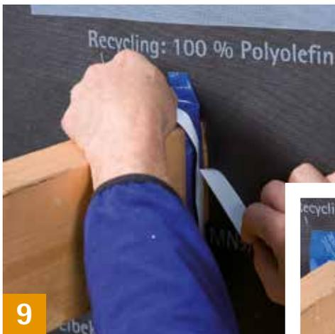
Winddichter und wasserführender Anschluss an Balken (gehobelt) mit Eckklebeband TESCON PROFIL herstellen. Durch die geteilte Trennfolie kann zunächst am Balken, im folgenden Schritt auf der Bahn verklebt werden. Reihenfolge der Verklebung: 1. unten, 2. links und rechts, 3. oben. Anschluss an raue Balken mit Anschlusskleber ORCON F oder ORCON CLASSIC.
