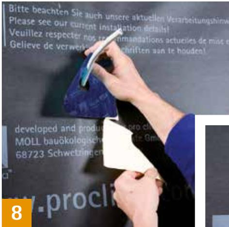
pro clima KAFLEX Kabelmanschette aus EPDM über das Kabel ziehen und auf die Bahn führen. Trennpapier abziehen und verkleben. Auf ausreichenden Gegendruck achten, fest anreiben. Für Rohre ROFLEX Rohrmanschetten verwenden.
