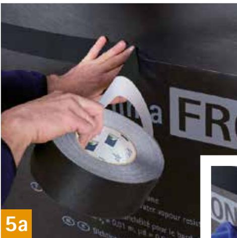
Für nicht sichtbare Verklebungen und Anschlüsse von Wandschalungsbahnen hinter Lückenschaltungen TESCON INVIS mittig auf der Bahnenüberlappung ansetzen, abwickeln und Zug um Zug verkleben.
