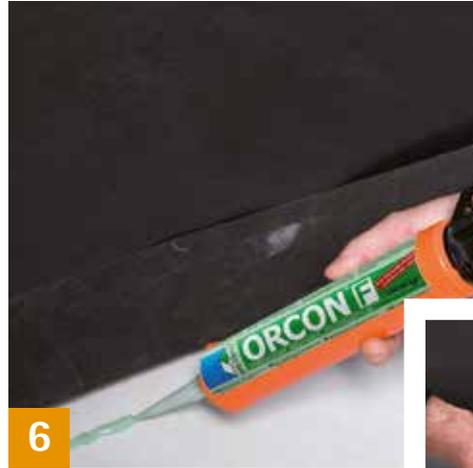
Anschluss an Bodenplatte oder andere mineralische oder raue Untergründe mit dem Anschlusskleber ORCON F oder ORCON CLASSIC. Untergrund reinigen. Ca. 5 mm dicke Kleberaupe auftragen (bei unebenen Untergründen ggf. mehr). Bahn mit einer Dehnschleife in das Kleberbett legen. Kleber nicht ganz flach drücken, damit Bauteilbewegungen aufgenommen werden können. Nach dem Andrücken sollte die Kleberaupe noch mindestens eine Dicke von 2-3 mm aufweisen.
