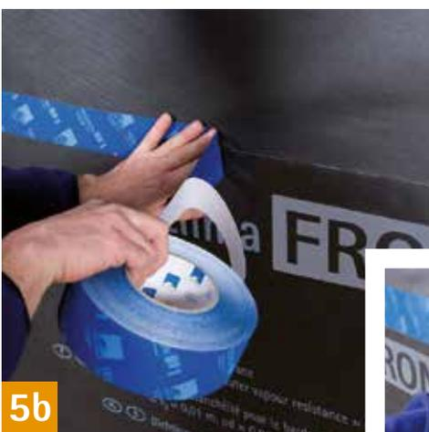
Alternativ: Sichtbare Verklebung der Bahnenüberlappung mit den Allround-Klebebändern für innen und außen TESCON No.1 und TESCON VANA.
