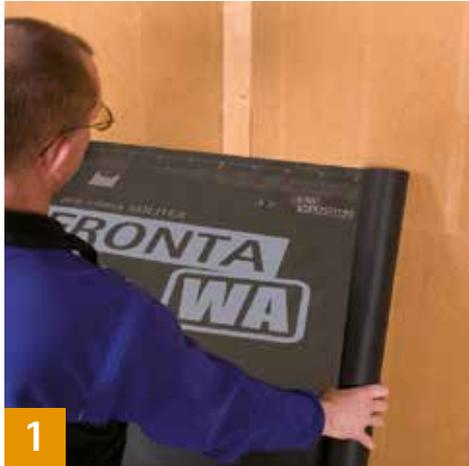
Erste Bahn horizontal ausrollen und in Waage ausrichten. Ggf. vorher Markierungen am Ständerwerk anbringen.
