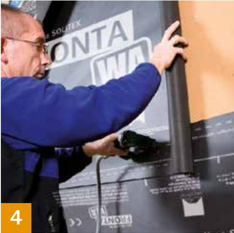
Zweite Bahn ausrollen, wasserführend ca. 15 cm überlappen lassen und fixieren. Ausrichtung an der Strichlinie möglich.
