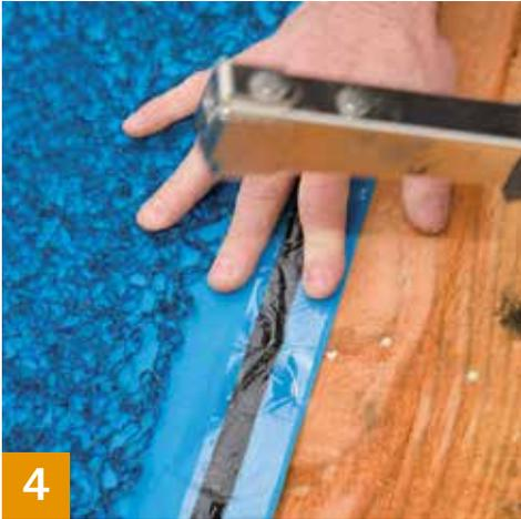
SOLITEX UM connect im Überlappungsbereich mit verzinkten Tackerklammern fixieren. Klammern sollten 10 mm breit und 8 mm lang sein. Abstand 10-15 cm. Zur Verbesserung des Schutzes vor eindringendem Wasser in der Bauphase zwischen Selbstklebezonen und Bahnaußenkante tackern.
