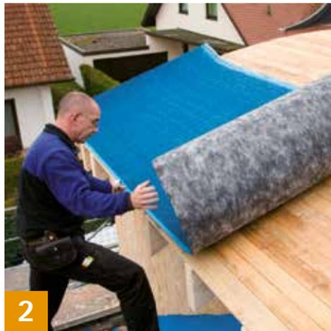
pro clima SOLITEX UM connect parallel zur Traufe ausrollen und wasserführend verlegen. Die Gewirrlage zeigt nach außen/oben.
