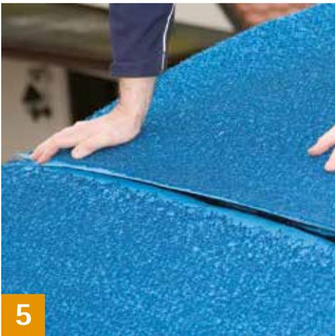
Zweite Bahn ausrollen, ausrichten und wasserführend überlappend verlegen. Im Überlappungsbereich ist die 3D-Gewirrlage abgesetzt. Die Überlappungsbreite wird somit vorgegeben.
