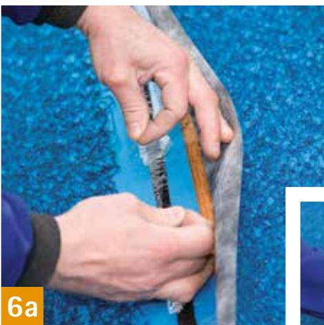
Zweite Bahn hochschlagen, Trennfolie abziehen und Bahnen Zug um Zug mit integriertem Selbstklebestreifen verkleben.
