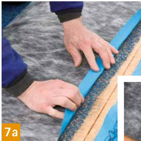
Für Verklebungen im Bereich von Kopfstößen 3D-Gewirrlage von der unteren Bahn auf ca. 10 cm Breite lösen und anschließend ca. 4-5 cm Gewirr abschneiden. Bahn verlegen und im Überlappungsbereich fixieren.
