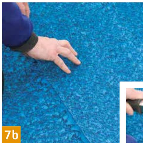
Obere Bahn auf der unteren Bahn ausrichten, überlappend verlegen und fixieren.
