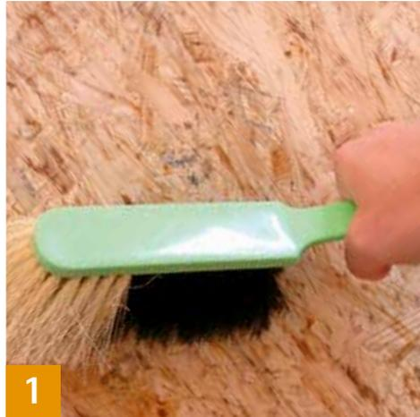
Scharfkantige oder spitze Gegenstände (z. B. Nägel), die aus der Schalung ragen, entfernen. Untergründe abfegen, ggf. absaugen und abwischen.
