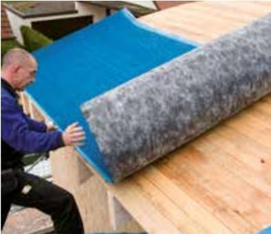
Unterdeck-System für Blechdächer mit 4-lagiger hochdiffusionsöffener Unterdeckbahn. Mit 3D-Trennlage aus 8 mm starkem PP-Gewirr und Butylselbstklebestreifen. Die SOLITEX UM connect ist mit einer monolithischen, porenfreien Funktionsmembran ausgestattet. Damit ist sie dicht gegen Wasser von außen und kann gleichzeitig Feuchte aktiv aus der Konstruktion ins Freie transportieren.
