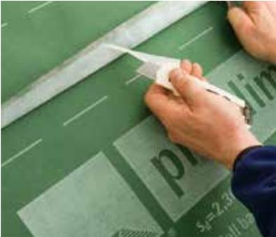
Dampfbrems- und Luftdichtungs-System für Aufdachdämmungen mit diffusionsoffener Unterdeckung. Robust, 3 Monate frei bewitterbar, DA connect mit zwei integrierten wasserfesten Selbstklebezonen. Die pro clima DA schützt das Bauwerk schon während der Bauzeit vor Witterungseinflüssen. Ihre Membran ist wasserdicht – gleichzeitig ist ihr Diffusionswiderstand leicht diffusionshemmend eingestellt.
