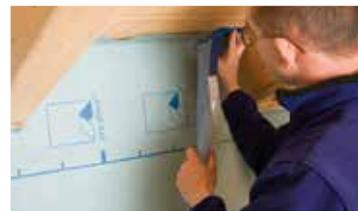
Eine der pro clima Dampfbremsen (hier DB+) innen ausschneiden, zwischen die Sparren einpassen und mit TESCON PROFIL luftdicht anschließen.
