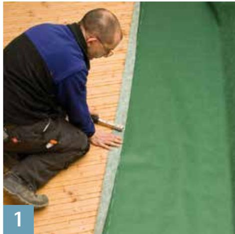
Sind Kehlen vorhanden, zunächst die Bahn hier ausrollen, Randbereich umklappen und mit Klammern fixieren.
