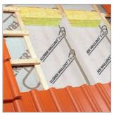
Die Dampfsperre Wallint® 2 eco kann parallel zum Sparren oder traufparallel, wannenförmig über den Sparren verlegt werden (bedruckte Seite der Bahn muss nach außen zeigen) und muss gemäß ZVDH Vorgabe im unteren Sparrenbereich mechanisch befestigt werden. Die Verklebung der Stöße ist mit unseren zugelassenen Klebematerialien wie z.B. Klöber Permo® TR plus oder Pasto® auszuführen.
