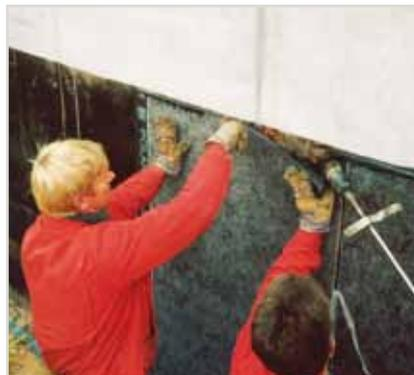
Außenwandabdichtung wird vollflächig angeschweißt.
