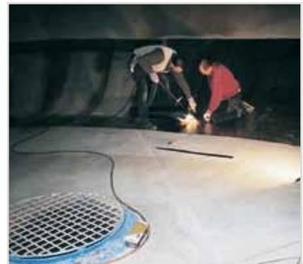
Innenabdichtung des Trinkwasserbehälters in einem Wasserturm
