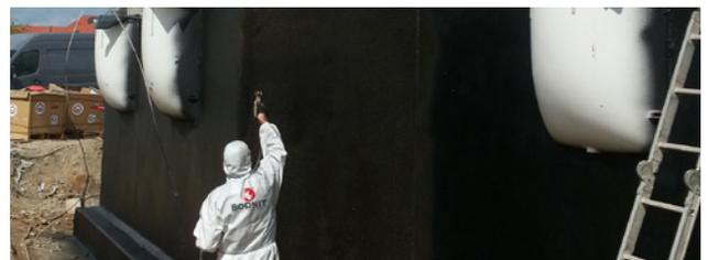
\* Mineralflex 2K ist eine Flexible Polymere Dickbeschichtung (FPD) und noch nicht Bestandteil der DIN 18533. Es sind Sondervereinbarungen abzuschließen.
