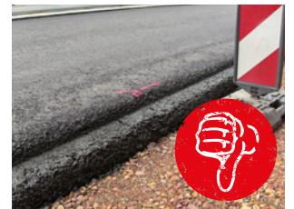
Mittelnahrt einer Trag-/ Binderschicht Naht
