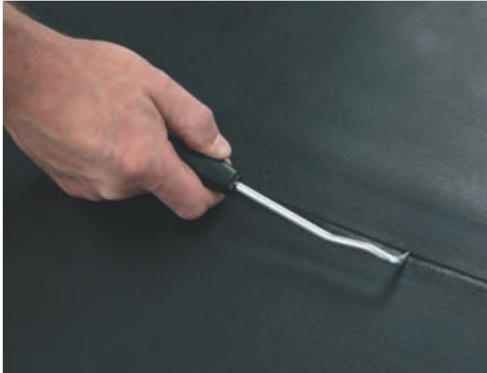
Zur Versiegelung von geschweißten und kontrollierten Nähten dient WOLFIN flüssig. Eine Versiegelung der Bahnenkante ist bei einem homogenen Bahnenrand nicht erforderlich.
