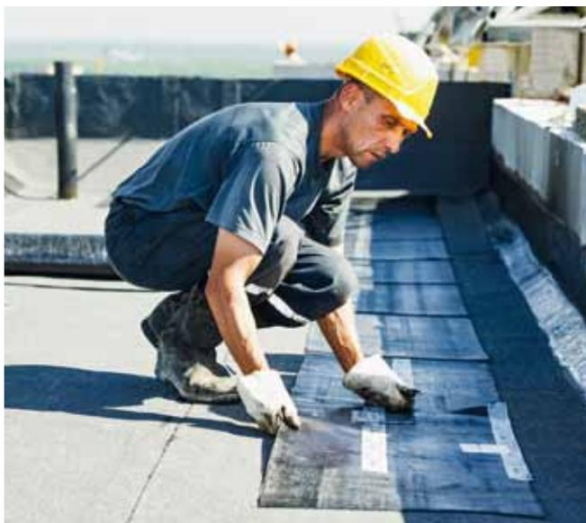
Beim Kompaktdachaufbau werden alle Schichten miteinander mit Heißbitumen verklebt. Diese besondere Form des Dachaufbaus verhindert die Unterlüufigkeit der Konstruktion und schadhafte Stellen in der Dachabdichtung wirken sich nur örtlich begrenzt aus. Beim Kompaktdach kommen die mineralvlieskaschierten **UNILIN PIR M Dämmplatten** zum Einsatz. Die weiteren Komponenten sind mit den jeweiligen Herstellern abzustimmen.
