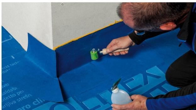
**12. Bei flach geneigten Dächern: Anschluss an aufgehende Bauteile (z. B. Schornstein)**
