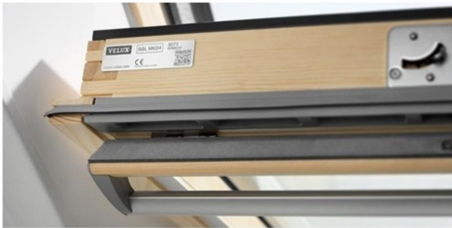
Das Typenschild Ihres Fensters finden Sie bei geöffnetem Fenster rechts oder links hinter der Griffleiste.
