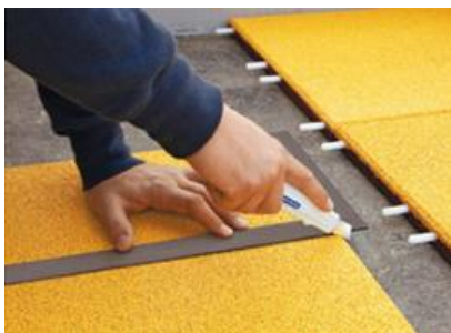
Abb. 6: Zuschneiden mit Teppichmesser
