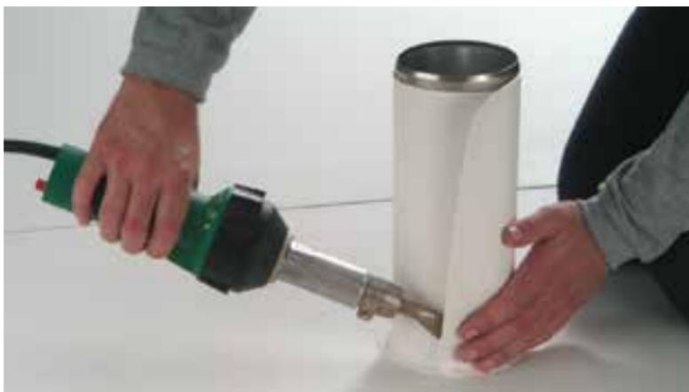
**2.** Den Flansch quadratisch/rund aus Cosmofin F zuschneiden (Abmessung min.  $\varnothing$  Rohr + ca. 250 mm) und mit einem mittigen runden Loch versehen ( $\varnothing$  Loch = Rohrdurchmesser – ca. 40 mm). Die Bahnenkante im Loch erwärmen und leicht dehnen.
