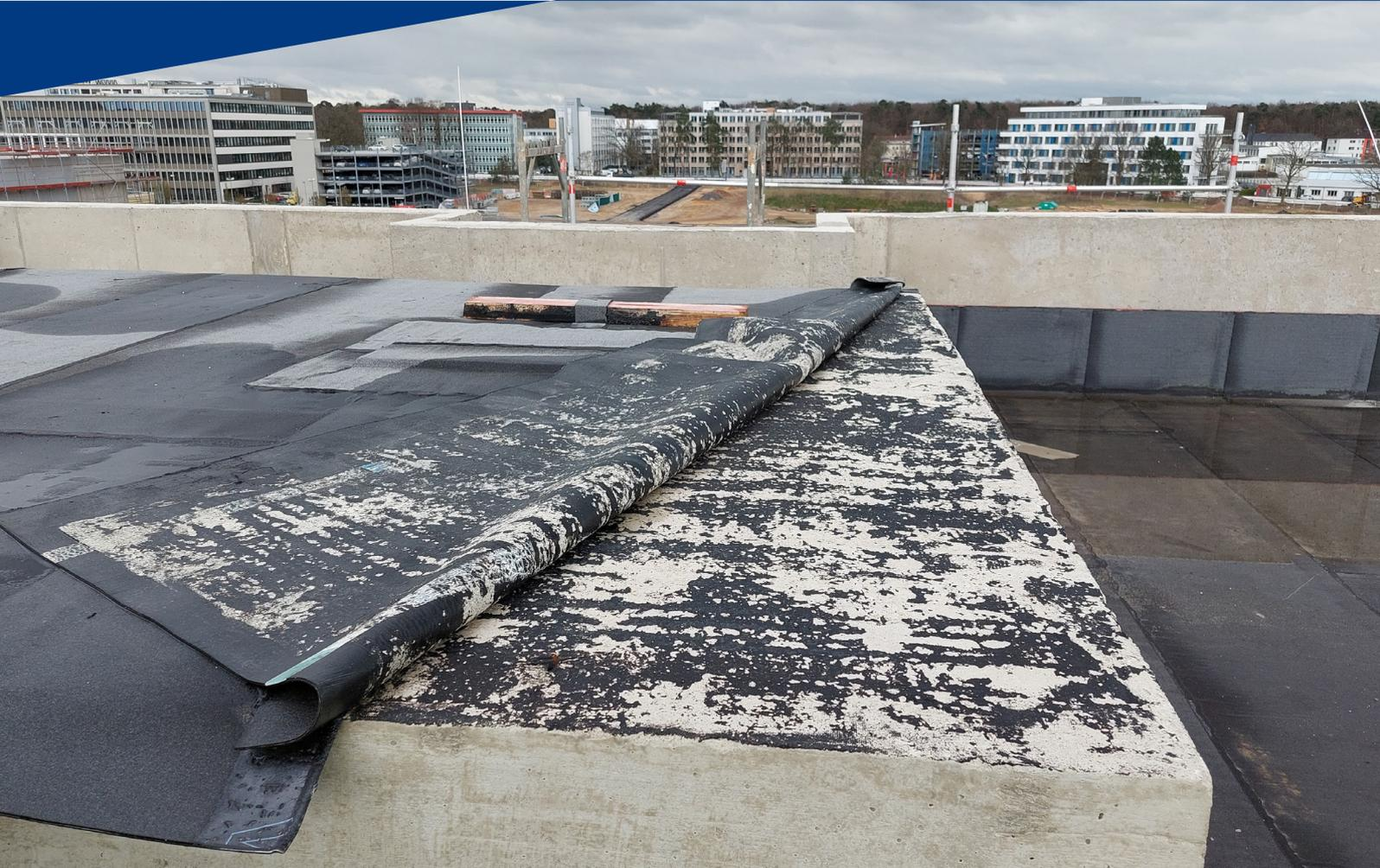
Diese Arbeitsempfehlung soll eine Hilfestellung im Arbeitsalltag sein, um prüfen zu können, ob eine Haftung von Bitumenbahnen zum Betonuntergrund erzielt wird.
