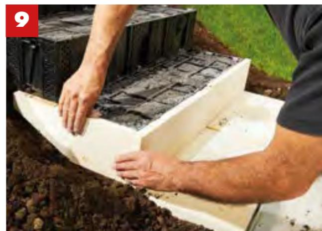
Die verfüllten Stufen mit dem gewünschten Material verkleiden.
