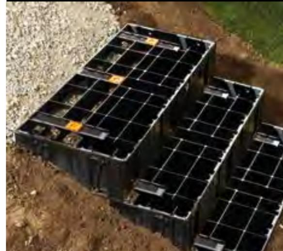
Schaufel, Wasserwaage, Schraubenzieher und Modulesca ist alles, was für die Gartentreppe gebraucht wird.
