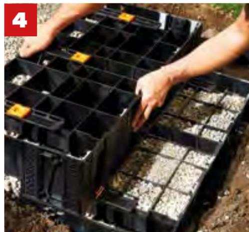
Die erste Stufe ausrichten, 1% Gefälle nach vorne wegen Wasserablauf.
