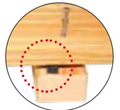
Das einseitig klebende Distanzband wird auf die Unterkonstruktion geklebt. Im Anschluss werden die Dielen von oben verschraubt.
