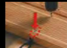
Mit diesem Distanz- und Abstandshalter lassen sich Terrassendielen aller Holzarten besonders einfach und schnell und verlegen. Der Bolzen fungiert als Distanzhalter und garantiert ein einheitliches Fugenbild. Der Abstandshalter verhindert das komplette Aufliegen der Dielen auf der Unterkonstruktion. Auf diese Weise ist eine optimale Hinterlüftung gegeben, Staunässe wird verhindert.
