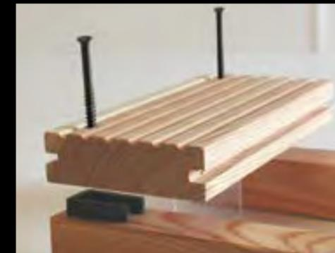
Anfangs-/Abschlusskomponente als Abstandshalter unter die erste Diele setzen. Der Quersteg muss nach oben zeigen. Anfangsdielen vorbohren.
