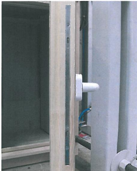
**Bild 9** Verriegelung Flügelteil
