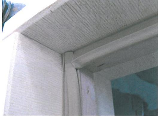
**Bild 5** Dichtungsstoß
