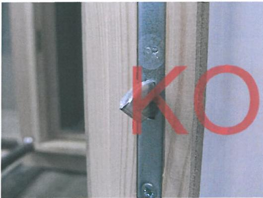
**Bild 6** Verriegelung Flügelteil
