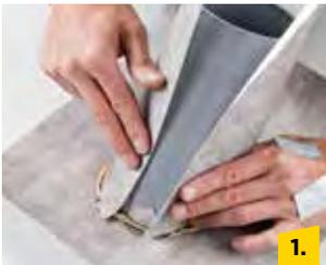
Abdichtungen für Dachdurchdringungen können einfach selbst gebaut werden. Das ist praktisch und sicher.
