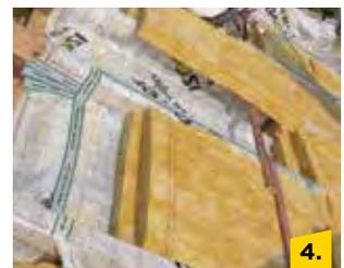
So kann von außen die Klimamembran mit einem Dichtstoff (Vario® DoubleFit oder Vario® ProTape Xtern) oder einem Klebeband (Vario® MultiTape) befestigt werden. Von innen wird später analog verfahren.
