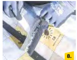
Mit Vario® MultiTape SL offene Kante abdichten. Passend abgelängtes Band in der Mitte vorfalten, eine Hälfte des Abdeckstreifens abziehen und auf der hinteren Kante ankleben. Das SL steht für „Split Liner“ und beschreibt den getrennt abziehbaren Abdeckstreifen.
