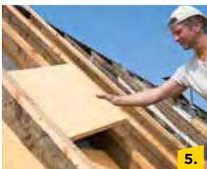
5. Weiterer Vorteil: Sparren verlieren an Holzfeuchte und schwinden: So werden ehemals gerade zu ungeraden Sparrenhöhen. Um dennoch die Gefache maximal zu nutzen und eine passgenaue Dämmstoffhöhe zu erzeugen, kann Integra UMP-032 auch für den Höhenausgleich verwendet werden.
