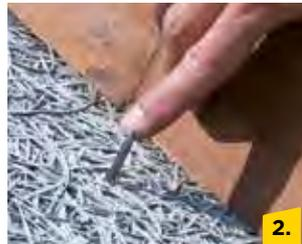
2. Vorteil: Integra UMP-032 Universal-Modernisierungsplatte als Nagelschutzplatte aufbringen. Sie schützt die darüberliegende Dampfbremssfolie, wenn Nagelspitzen aus der Innenbekleidung herausstehen.
