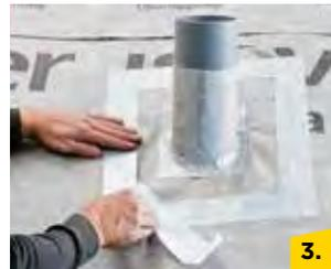
Die vorbereitete Rohrabdichtung über das Rohr stülpen und Abdeckstreifen entfernen.
