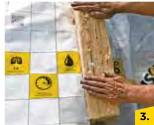
Integra UMP-032 (ggf. mehrlagig) zu einem passenden Paket zusammenfassen und mit der Folie ins Gefach drücken. So ist gewährleistet, dass die Folie am Sparren anliegt und das ganze Gefach optimal ausgedämmt ist.
