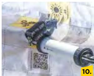
Überstehendes Band entlang der Faltung einschneiden, Klebebandstreifen umschlagen und verkleben.
