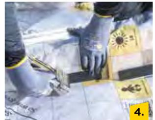
Sind Zangen zur Aussteifung des Dachstuhls oder zur Einbindung einer Decke vorhanden, kann Vario® KM Duplex UV nicht einfach über diese hinweggelegt werden: Darunter bilden sich zahlreiche Falten und Hohlräume, die durch Hinterströmung Bauschäden verursachen können.
