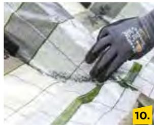
Vorsichtig andrücken. Tipp: Wenn etwas zu tief eingeschnitten wurde, mit Dichtstoff großzügig auffüllen und mit Klebeband fixieren.
