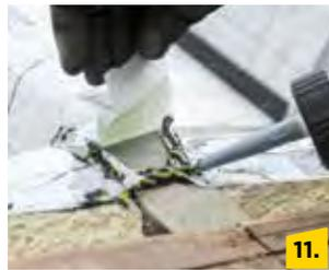
Nun die Einschnitte an der Klimamembran am Sparrenkopf mit Vario® XtraFit abdichten und mit Klebeband Vario® XtraTape fixieren.
