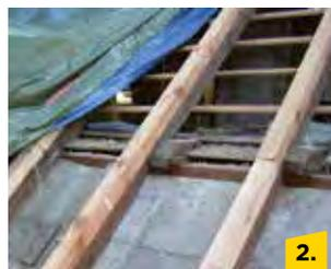
Jeder einzelne Sparren durchdringt dann genau in der Höhe der trennenden Decke die Folienebene – eine luftdichte Abdichtung wäre unmöglich.
