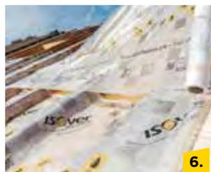
6. Vario® KM Duplex UV über die Sparren ausrollen, dabei waagrecht von der Traufe in Richtung First mit 10 cm Überlappung verlegen. Schrift lesbar zum Verarbeiter zeigend. Vorläufige Fixierung der Klimamembran im Gefach mit Handtacker. Bei der geraden Ausrichtung hilft das aufgedruckte Zuschnittstraster.
