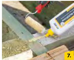
Zur Haftverbesserung den Untergrund mit Vario® MultiPrime vorbehandeln. Dosiermenge lässt sich über Drehverschluss einstellen.
