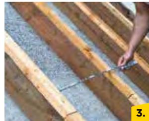
3. Gefachbreite ausmessen, Platten passend zuschneiden, zeilenweise ins Gefach einlegen.
