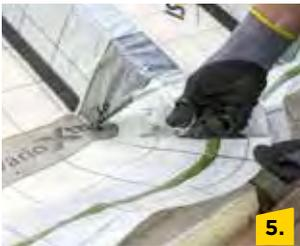
Vario® XtraSafe gerade seitlich am Sparren nach unten ziehen und bis zur Ecke senkrecht einschneiden.
