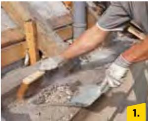
1. Bestehende Dacheindeckung abnehmen und alte Lattungen demontieren. Gefach leeren und säubern. Alte Dämmung fachgerecht entsorgen.
