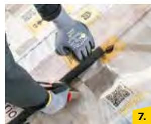
7. Die Klimamembran mit Vario® ZSL Sanierungsleisten sauber in den Ecken fixieren, damit keine Hohlräume dahinter verbleiben, die mit Luft hinterströmt werden könnten. Leistenabstand etwa 30 cm. Hinweis: Bei offener Innenbekleidung durchgängig verlegen.
