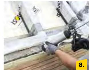
Zuerst alle gefachbreiten Anschlüsse der Klimamembran mit Vario® XtraFit herstellen.
