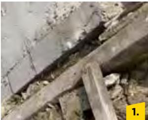
Im Gefach zwischen Streichsparren und Giebelwand oder an Gebäudetrennwänden ist es schwierig, die Klimamembran zu befestigen, da das Gefach zu schmal ist. Auch die Fixierung mit Tacker/ZSL-Leisten funktioniert hier nicht.
