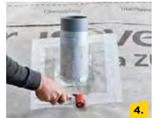
Den Klebebereich am Rohr mit Schleifpapier anrauen und mit Vario® SilverFast verkleben.
