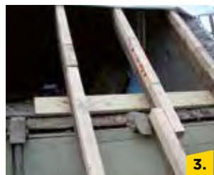
Deshalb wird eine OSB-Platte als sog. „Wechselbrett“ auf der Innenseite der Sparren oberhalb der einbindenden Decke angeschraubt. Ziel: ein Medium zu schaffen, an das von beiden Seiten mit einer Folie und Klebebandern luftdicht angeschlossen werden kann.
