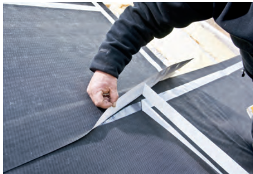
Klebebänder ober- und unterseitig integriert
