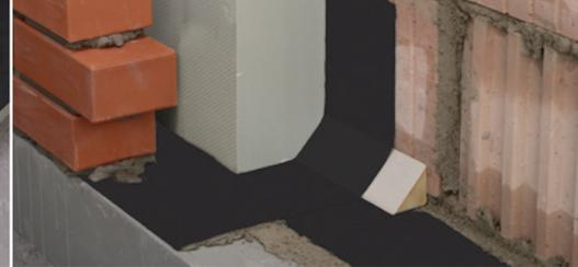
Seitlicher Überstand für Verbund mit Abdichtungsschichten.
