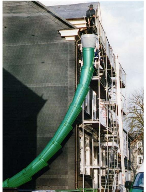
Die vorschriftsgemäße Verwendung und Montage von Schuttröhren ist unbedingt zu beachten, z.B. Ausrichtung der Schuttröhreitung ohne Bildung von Prallflächen, mit Manövrierleine, zum direkten Einleiten des Bauschuttes in einen Container. Zum staubfreien Einleiten Staubmanschetten und Containerabdeckplane bestellen.
