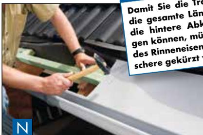
Die Traufstreifen bieten zusätzlichen Schutz vor Regenwasser und Flugschnee. Sie werden in die Abkantung der Dachrinne eingehängt und mit Pappstiften alle 30 cm auf der Dachlatte festgenagelt. Traufstreifen werden mit einer Überlappung von mindestens 4 cm verlegt.
