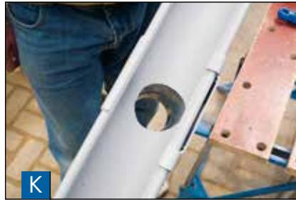
Die Sägekante entgraten und den Rinnenstützen über die hintere Abkantung einhängen und über den vorderen Wulst klippen.
