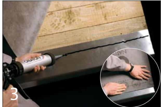
3 Bei einem regensicheren Unterdach erfolgt die Verklebung an der Traufe durch das integrierte Nahtklebeband oder den systemgerechten CREATON Spezialkleber SKL.
