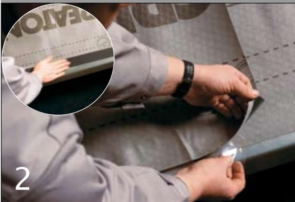
2 An der Traufe bzw. Regenrinne sind die Bahnen auf ein Tropf- oder Rinneneinlaufblech zu führen und mit diesem zu verkleben. Bei einer Unterspannung bzw. Unterdeckung erfolgt die Regeneintragssicherheit durch das integrierte Nahtselbstklebeband oder den CREATON NagelDichtStreifen NDS.
