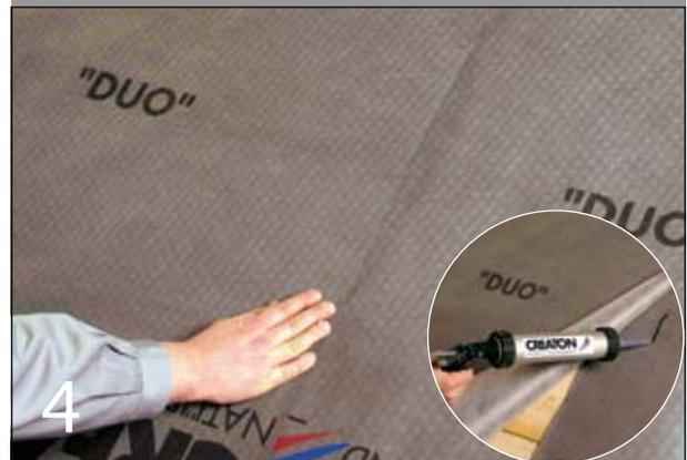
4 Die Quernähte bei einem regensicheren Unterdach werden mit dem systemgerechten Spezialkleber SKL verklebt. Dieser wird aus der Kartusche direkt auf die Bahn aufgetragen. Die Bahnen werden daraufhin im Bereich der Verklebung umgehend angedrückt, um die sichere Verklebung zu gewährleisten. Der Klebepbereich muss trocken und staubfrei sein.
