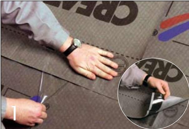
1 Die Bahnen sind waagrecht zum Dach zu verlegen. Die Überlappung der Längsnähte muss mit dem Gefälle erfolgen und darf nicht gegen die Dachneigung gehen. Die Bahnen sind mit einer Überlappung von ca. 15 cm zu verlegen und werden an den Längsnähten mittels des integrierten Selbstklebebandes miteinander verklebt.
