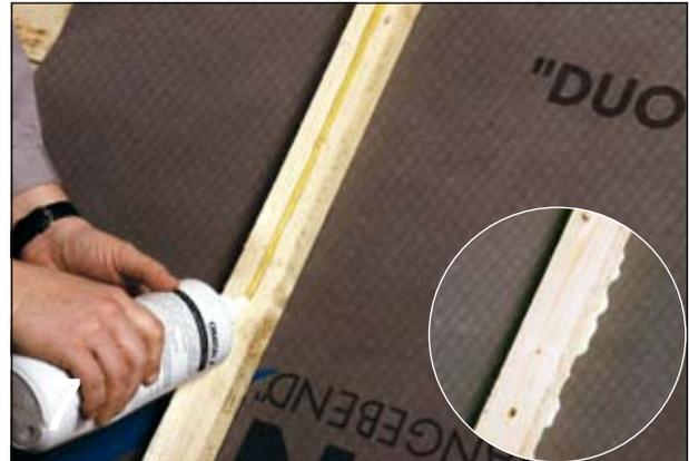
Die NDM wird mittels Dosierflasche, nach Fixierung der CREATON Unterdachbahn als Raupe mittig auf die Konterlatte aufgetragen. Die Konterlatte drehen und mit der Unterkonstruktion verbinden. Vor dem Auftragen muss die Fläche trocken, sauber, entstaubt, entölt und tensidefrei sein.
