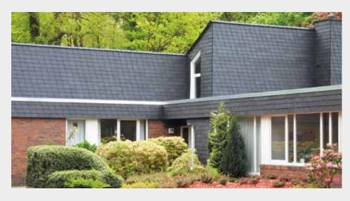
Die Waagerechte Deckung ist eine querformatige Rechteckdeckung, die mit vollkantigen oder eckengestutzten Schiefern ausgeführt wird.
