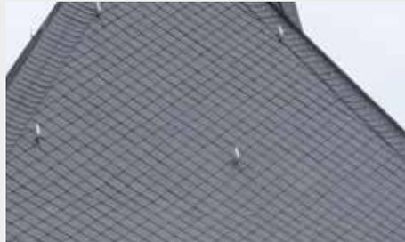
Die Spitzwinkelschablonen sind mit mindestens 2 Schiefelnägeln oder -stiften zu befestigen. Die Größe der Spitzwinkelschablonen ist abhängig von der Dachneigung.
