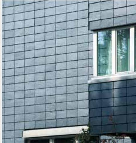
Die untergelegten Steine sind mit 2 Nagel- bzw. Schraubenbefestigungen und ab dem Format 50/25 zusätzlich mit einem Einschlaghaken zu befestigen. Die aufgelegten Steine sind bis zu einer Sicht-/Stoßfugenbreite < 5 cm mit einer Nagel- bzw. Schraubenbefestigung und einem Einschlaghaken, > 5 cm Fugenbreite wie vor jedoch mit 2 Einschlaghaken zu befestigen.
