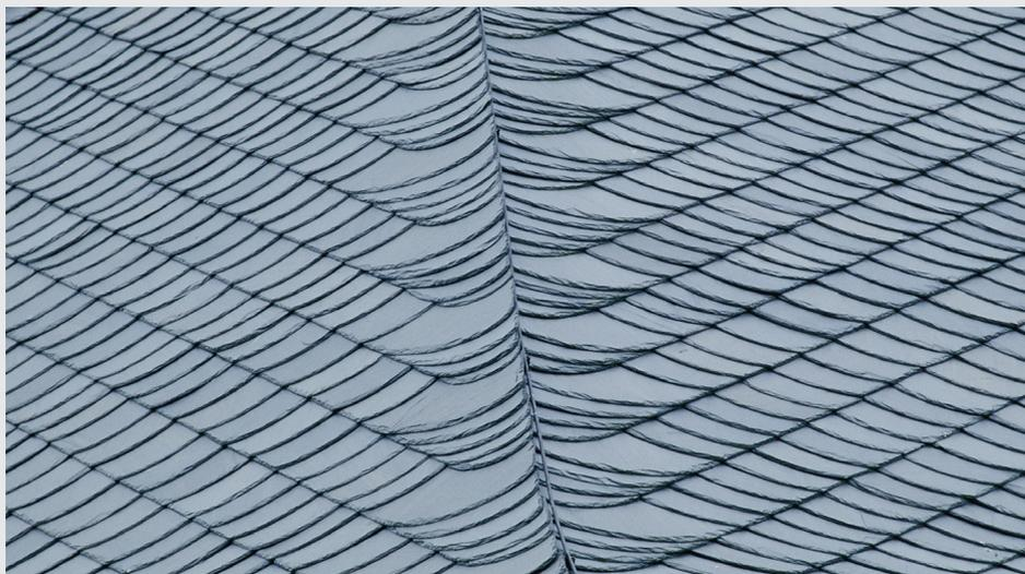
Die Wahl der Deckrichtung kann von der Hauptwetterrichtung und von der Deckrichtung der Kehle abhängen.
