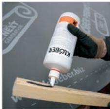
Abgestimmtes Nageldichtmaterial, z.B. Permo® seal, Butylon® oder Pasto®.
