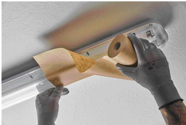
PAPER PROTECT mittels klebender Unterseite auf beliebigen Untergrund anbringen. Nach fertiger Arbeit ist das Kraftpapier rückstandslos entfernbar.
