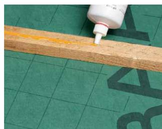
2. Divoroll Dichtmasse auf die Konterlatte auftragen
