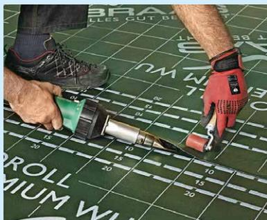
Sichere Verschweißung mit einem Heißluftföhn
