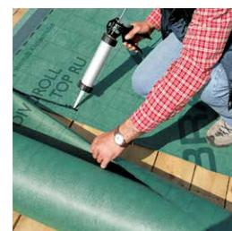
3. Verklebung von Querstößen und aufgehenden Bauteilen
