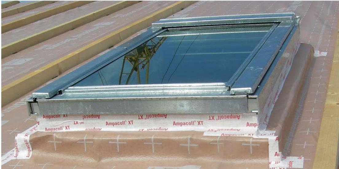
01\_Dachfenster mit **Ampatop® Secura** und **Ampacoll® XT 60**, zweifach geschlitzt
