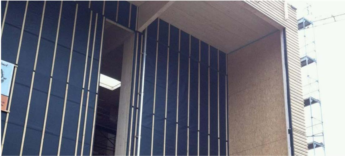
Verkleidungen aus Holz oder Metall werden aus gestalterischen Gründen oft mit offenen Fugen verlegt, um eine Fassade strukturierter und weniger flächig erscheinen zu lassen. Die dahinterliegende Dämmschicht ist damit jedoch erhöhten Belastungen in Form von Schmutz und Feuchtigkeit ausgesetzt. Mit **Ampatop® F black** ist die Wärmedämmung bei allen hinterlüfteten Fassadenkonstruktionen mit offenen Fugen von einer Breite bis zu 30 mm sicher verpackt.
