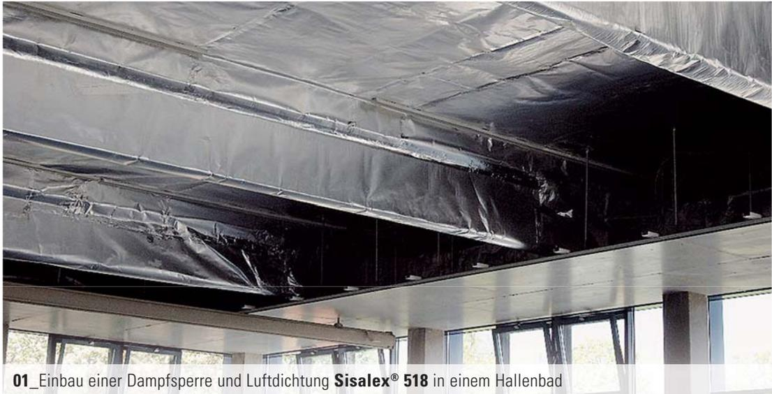
01\_Einbau einer Dampfsperre und Luftdichtung **Sisalex® 518** in einem Hallenbad
