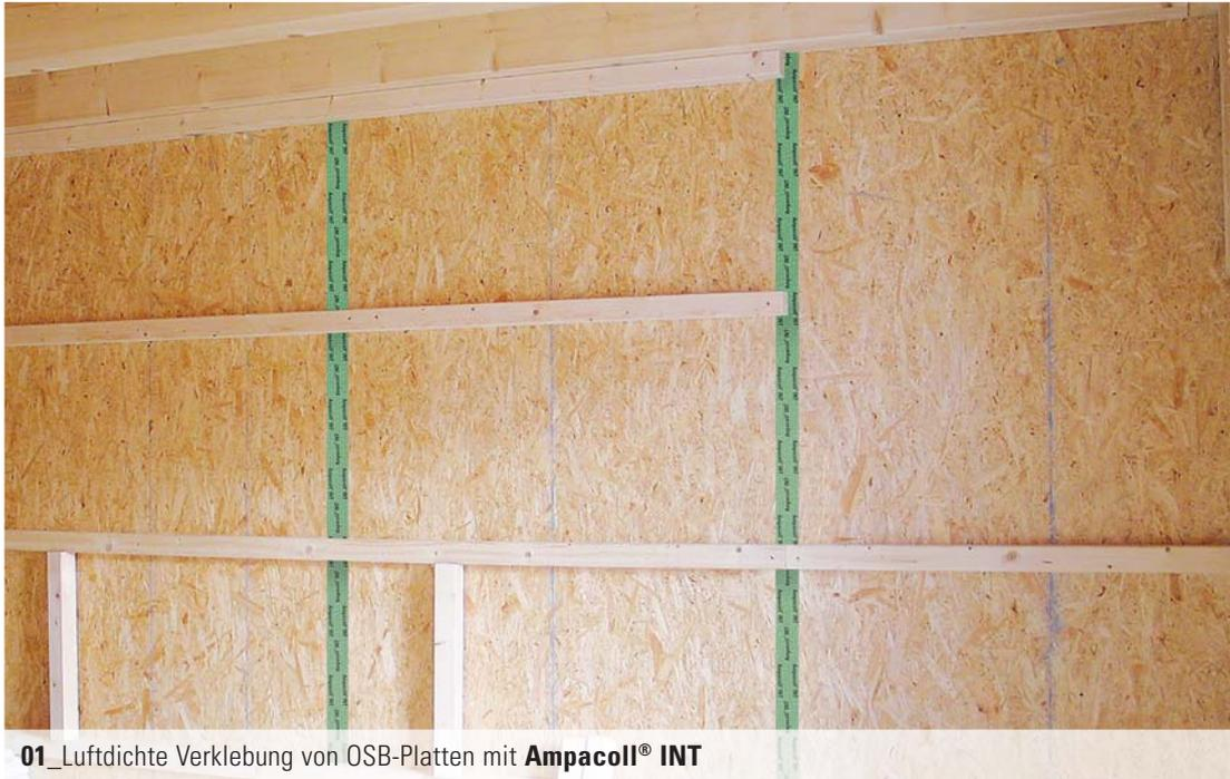
01\_Luftdichte Verklebung von OSB-Platten mit **Ampacoll® INT**
