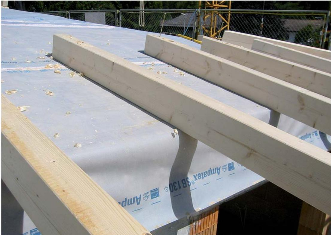
01\_Aufsparrendämmung mit Ampatex® SB 130. Überlappungsverklebung mit Ampacoll® XT
