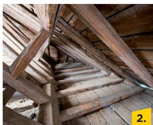
2. Um den zur Verfügung stehenden Platz effizient zu nutzen, empfiehlt sich folgende Verlegung: 1. Dampfbremse, 2. weiche Dämmlage zwischen den Balken, 3. Schalung, 4. begehbare Dämmung (von unten)
