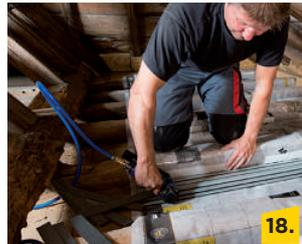
Vario® KM Duplex UV wird nach Säuberung der Gefache zwischen den Balken ausgerollt. Ein Lineal oder eine splitterfreie Latte hilft beim sauberen Andrücken in den Ecken. Folie mit Vario® ZSL-Leisten fixieren. Ca. 2 Stk./lfm.
