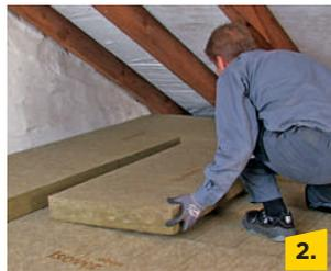
2. Zweilagige Verlegung mit versetzten Stößen erhöht die Dämmwirkung und verhindert zusätzlich Wärmebrücken.
