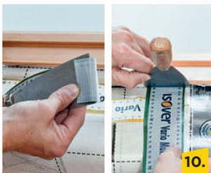
Überlappungskanten der Folie in den Ecken mit einem Streifen Vario® MultiTape verkleben. Tipp: Das Klebeband um einen Spachtel legen und damit tief in die Fensternut drücken.
