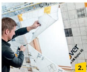
Klimamembran H-förmig (senkrecht an den Längsseiten und waagrecht in der Mitte) entlang der Fensteröffnung einschneiden, Folienlappen wegklappen und provisorisch mit Kreppband fixieren.
