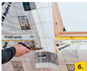
Die angefügten Folienlappen so weit parallel zur Strichmarkierung einschneiden, dass sich die Folie faltenfrei um die Laibungskante legen lässt.
