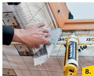
In den Ecken die Klebedichtmasse Vario® DoubleFit in die Nut spritzen und die überstehenden Folienlappen damit andichten.
