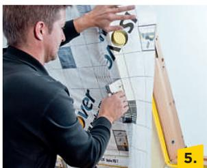
Das an den Fensterseiten fehlende Folienmaterial anfügen. Dazu zwei Folienlappen passgenau zuschneiden (Überstand zum Andichten in der Nut berücksichtigen) und am Sparren antackern.
