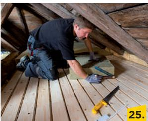
Neigungswinkel der Sparren mit einer Schmiege abnehmen und auf die Topdec Loft Platten übertragen. Zuschnitt mit dem Dämmstoffmesser.
