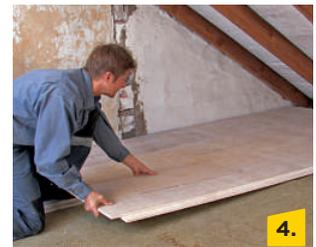
4. Verlegung des Gehbelags aus Gipsfaserplatten (z.B. Rigips Rigidur Estrichelement) oder alternativ Holzspanplatten P3.
