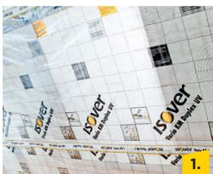
Klimamembran zunächst vollständig über den Fensterausschnitt führen und alle Folienüberlappungen verkleben.
