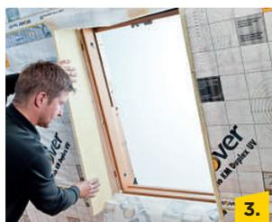
Vier Dämmstoffplatten (z. B. Integra UMP-O32) für die Fensterlaibungen bzw. den Fenstersturz passgenau in maximal möglicher Dicke zuschneiden und einbringen.
