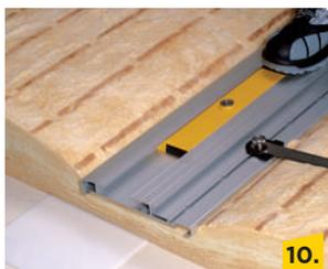
10. Durch Auftreten auf Integra FastCut den Dämmstoff komprimieren und fixieren.
