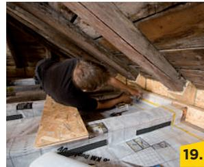
Folienpassstücke für den Randanschluss anzeichnen und zuschneiden.
