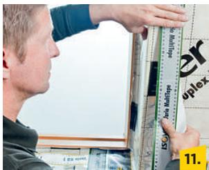
Die rundum entstandenen Stoßkanten mit dem Klebeband Vario® MultiTape verkleben.
