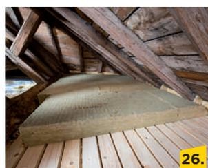
Verlegung der Topdec Loft Platten reihenweise, dicht gestoßen und mit Fugenversatz zwischen den Reihen.
