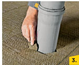
3. Bei Durchdringungen Dämmschicht sorgfältig schließen.
