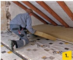
1. Auslegen von Topdec Loft auf der Geschossdecke (bei Holzbalkendecken Ausbildung einer Luftdichtheitsebene prüfen).
