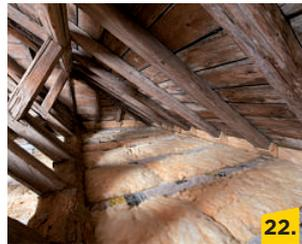
Die zweite begehbare Dämmlage Topdec Loft kann nicht direkt auf den Balken bzw. weicher Dämmung verlegt werden. Zuerst ist eine stabile flächige Unterlage zu erzeugen.
