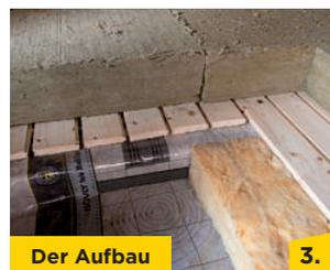
3. Die Klimamembran kann nicht eben zwischen den Dämmstofflagen liegen, da der zur warmen Seite gerichtete Dämmstoff mehr als 30% der Gesamtdämmung einnimmt. Daher wird sie schlaufenförmig verlegt.
