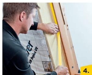
Den Dichtstoff von der Rolle Vario® ProTape Plus umlaufend an die Fensternut kleben. Dann die überhängenden Folienlappen auf Rahmentiefe einkürzen und in der Fensternut andichten.
