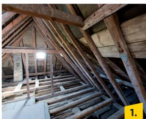
1. Die zu dämmenden Bodenflächen sind in einigen Teilbereichen direkt zugänglich, in anderen durch eine darüberliegende zweite Balkenlage in der Höhe begrenzt.
