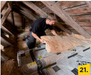
Nach der Verlegung der Dampfbremse beginnen die Dämmarbeiten mit dem Auslegen des Deckenfilzes Topdec DF 2 - oberflächenbündig mit den bestehenden Deckenbalken.
