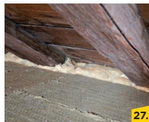
Die Lücken in den Gefachen bis zur Schalung werden mit flexibler Glaswolle gefüllt, z. B. mit Topdec DF 2.
