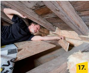
Ein weiteres Stellbrett verschließt den unteren Zwischenraum zwischen den Deckenbalken und beendet die Abdichtungsarbeiten an der Traufe.
