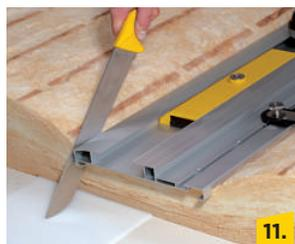
11. Dämmstoff entlang der Führungsschiene zuschneiden.
